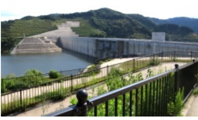
総貯水容量が県下最大の尾原ダム
